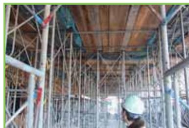
各階の躯体工事を追いかける形で、建物の内部仕上げ・設備工事を実施していきますので、建物の外枠はそれらしくなっても中はまだまだ未完成、といった感じですね。
