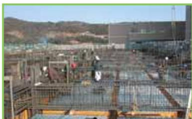
真です。この作業後にコンクリートを型枠に流し込んで固めた後、再び上の階の作業に取り掛かります。
