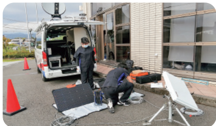
衛星通信システム構築作業
